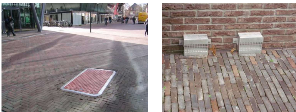
Figuur 3.3 | Ondergrondse afwerking van de putbehuizing (links) met ventilatievoorziening (rechts).
