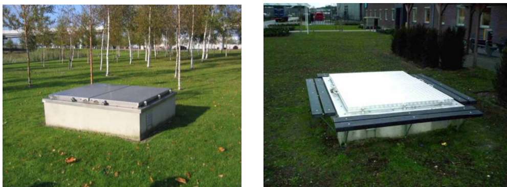
Figuur 3.2 | Half bovengrondse afwerking van de putbehuizing
